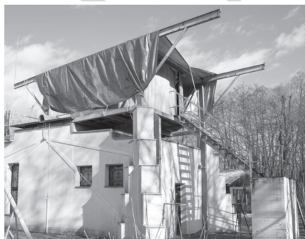
A Szegedi Csillagvizsgáló leszaggatott tetőszerkezete (balra) és az időjárás elleni ideiglenes megoldás (jobbra)
