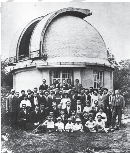
Vasmunkások a 8-as kupola előtt, az 1930-as években. A kupolák a bennük elhelyezett távcső hüvelykben mért átmérője után kaptak nevet ekkoriban. Ez tehát nem a nyolcadikként megépült kupola, hanem az 1-es számú (l. a 22. oldalon). Nyomatásban nem látható, de a legelső sorban bal szélén, a földön ülő kisfiú a Népszava című napilap egyik számát mutatja felénk. Sok más újsághoz hasonlóan a Népszava is gyakran foglalkozott a Svábhegyi Csillagvizsgálóval
