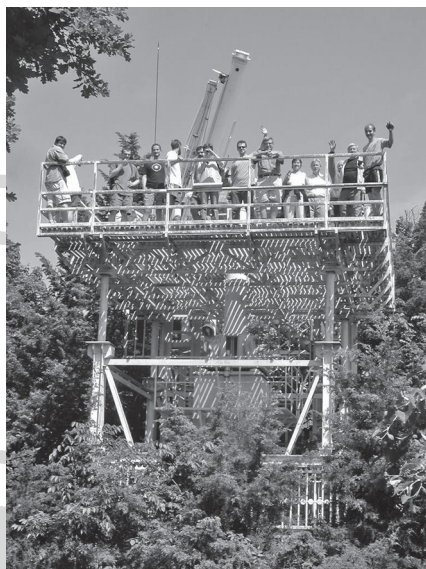
A debreceni observatóriumban a refraktort később megemelték, hogy kevésbé zavarja a képalkotást a lokális seeing. A magasban valamivel jobb a nyugodtság, mint a talajszinten, a rácsos szerkezetű észlelőplatform pedig megkönnyíti a levegő áramlását, keveredését (Tepliczky István felvétele)
