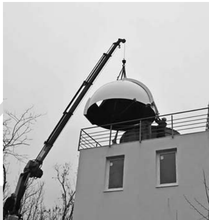
Minden csillagvizsgáló életének legizgalmasabb pillanata a kupola beemelése
