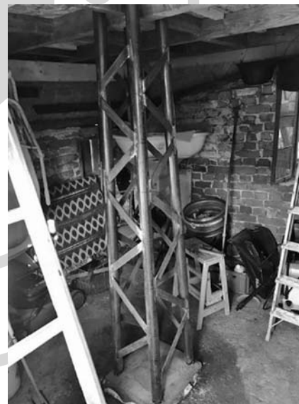
Erre a rácsos tartószerkezetre került a távcsőoszlop, 1,2 mély kútalapozással.
