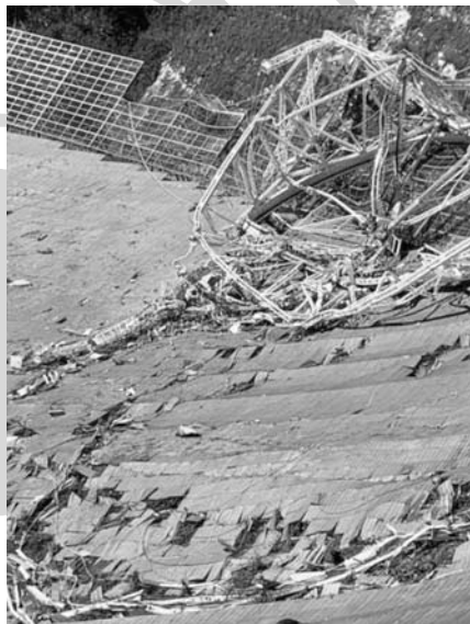
Közelkép a tányérba csapódott 900 tonnás platformról (UCF)
