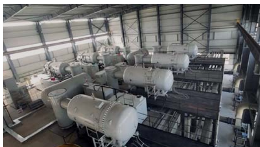
10. ábra. Ipari szennyvíz kezelése gamma-besugárzással ( 60 Co)
