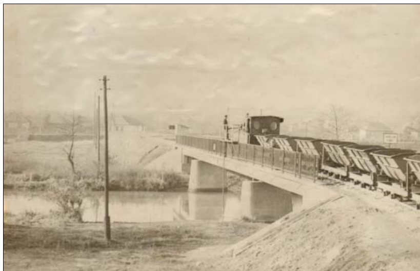
A szénszállítást szolgáló kisvasút híd a Bódván.
