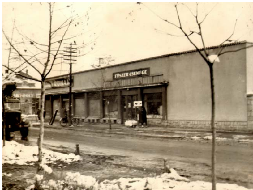
Az 1958-ban épült ruházati és fűszer bolt.
