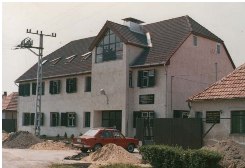
A csoki csomagoló 1989-ben. Előtte a gázvezeték építése látszik.
