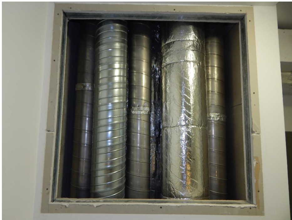
4. számú kép – Füstmentesítő rendszer szerelt aknájába telepített komfort szellőzések légcsatornái (szerző felvétele)
