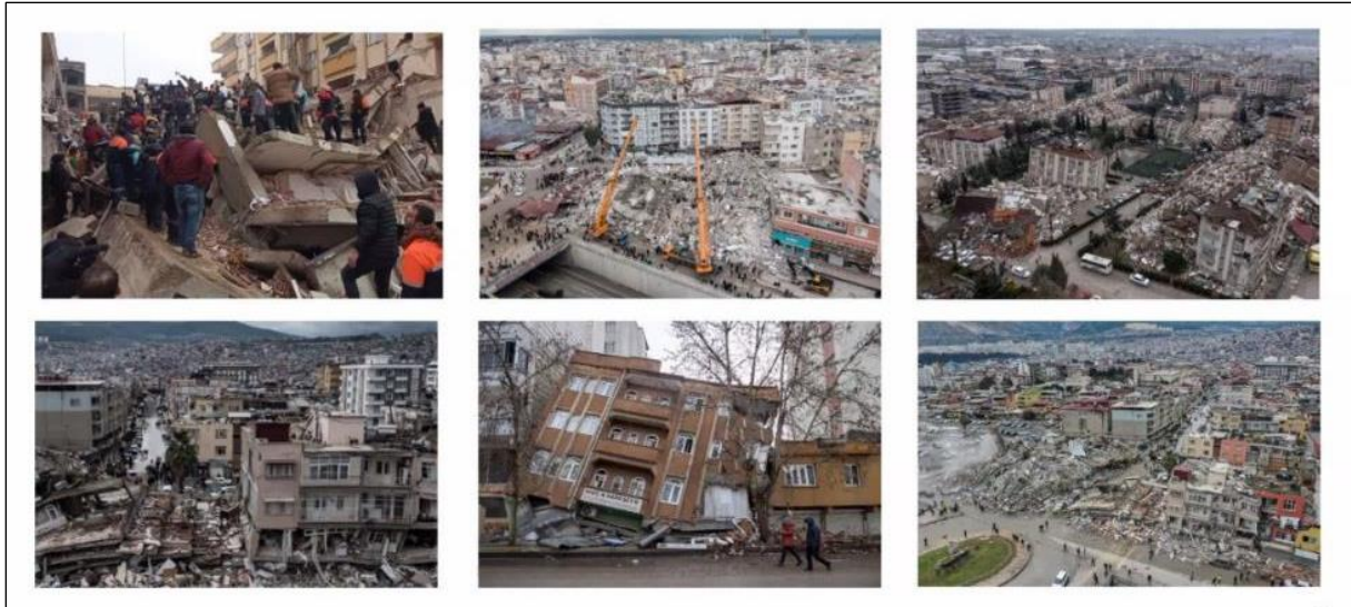
6. kép: Épületkárok (Forrás: ld. [15])
