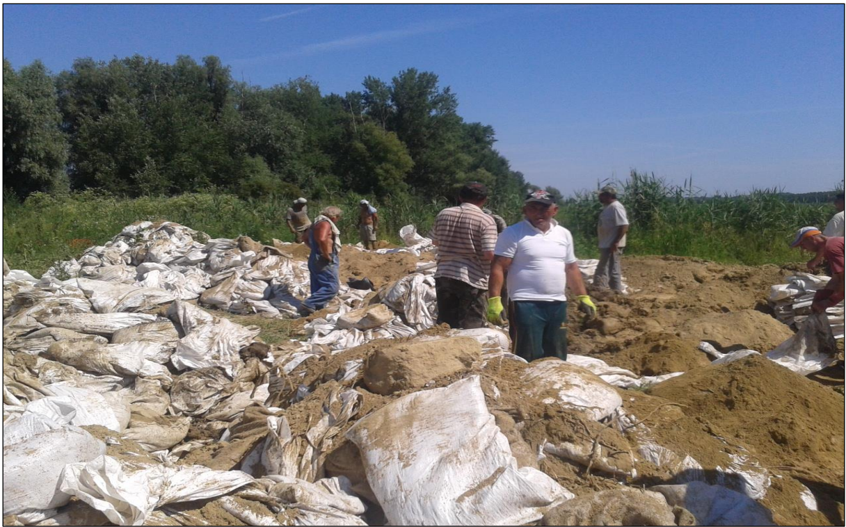
8. kép: A nyúlgát bontása (készítette a szerző)
