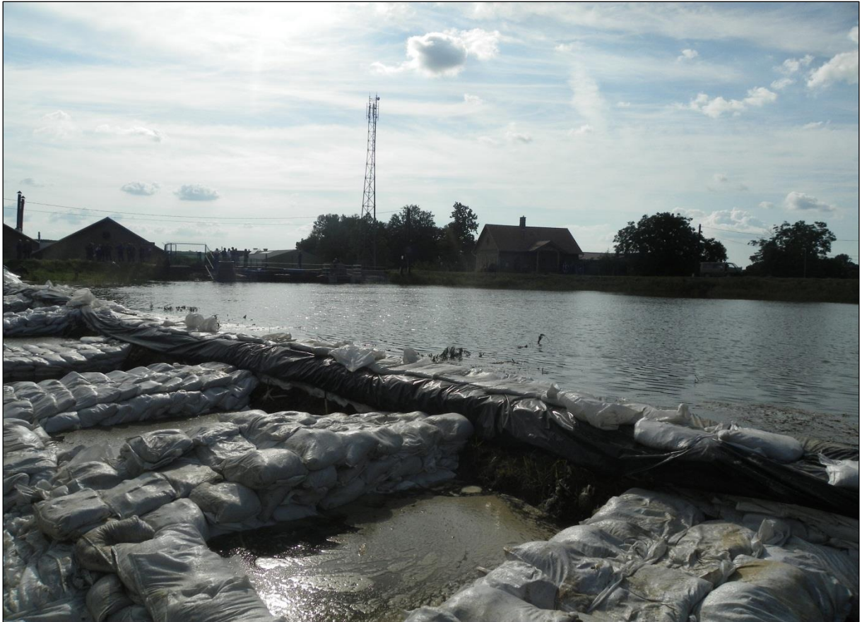
6. kép: Tetőzés a szivattyúháznál (készítette a szerző)
