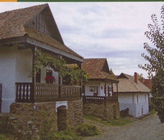
A vastag falak, a kis ablakok és a déli oldalon árnyékot vető tornác együttesen kellő védelmet nyújtottak a nyári meleg ellen, télen pedig ki lehetett fűteni
