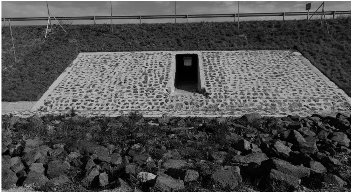
1. ábra: Vizsgálatba bevont közúti műtárgy képe
