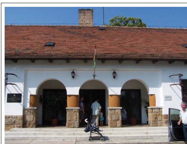
A Fajtakísérleti Állomás központi épülete
