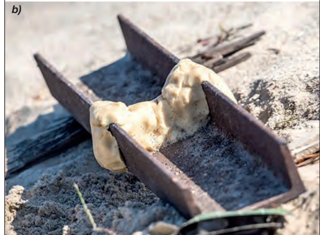
8. ábra. Peno plasztikus robbanóanyag 250 grammos kiszerelésben a) és acélprofil robbantásához előkészítve b) [18]
