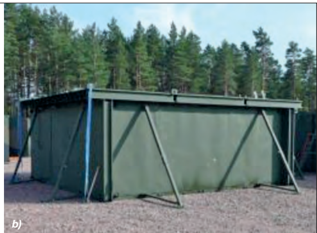
14. ábra. Balpro Protector elemek szállítási helyzetben a), illetve az elemekből készített zárt óvóhely b) [15]
