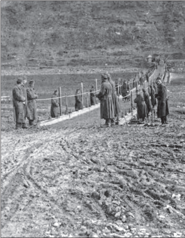
6. ábra. A Magyar Királyi Honvédség „Török Ignác” II. utászászlóalja által épített pontonhíd a Dnyeszteren, 1941 (Forrás: Fortepan / Teller Ferenc / 75466)
