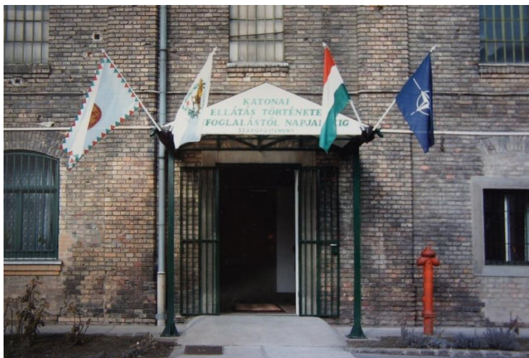
1. számú ábra. A Szakgyűjtemény Daróczi úti homlokzata
