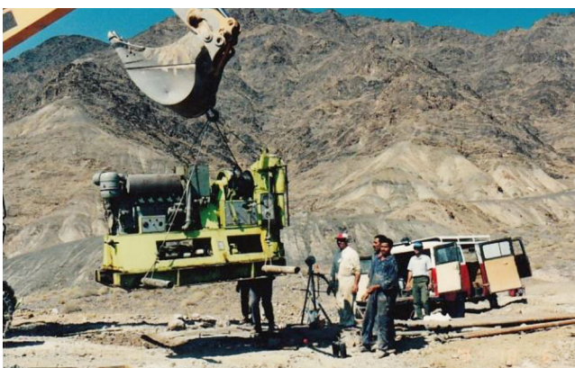
8. ábra. Fúrások előkészítése
