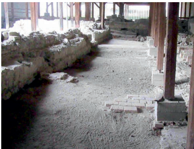
8. ábra. Hullámosan deformálódott és megsüllyedt padló a kerengő déli szárnyában, nyugatról nézve. Az eredeti téglaburkolatot fölszedték; most az ágyazóhabarcs felszíne látható. Ez a 6. ábrán jelölt 8. sz. helyszín. Az Archeoseizmológiai Adatbázis (ADB) #6699 sz. fényképe
