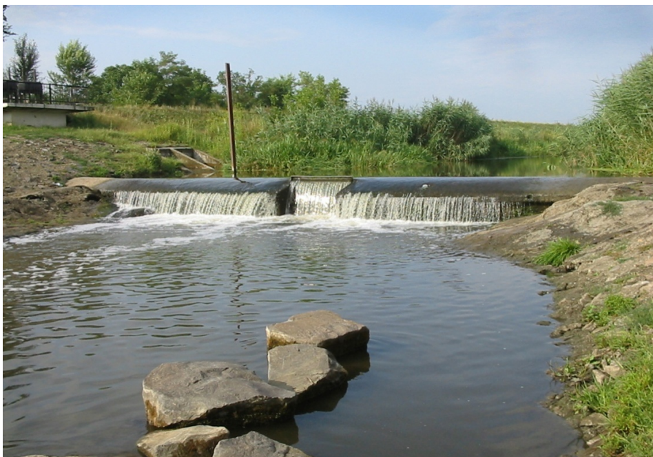
A jászberényi fenékküszöb (68,4 fkm) 2006-ban (Fotó: Harka Ákos) The bottom sill in Jászberény (68.4 rkm) in 2006 (Photo: Á. Harka)
