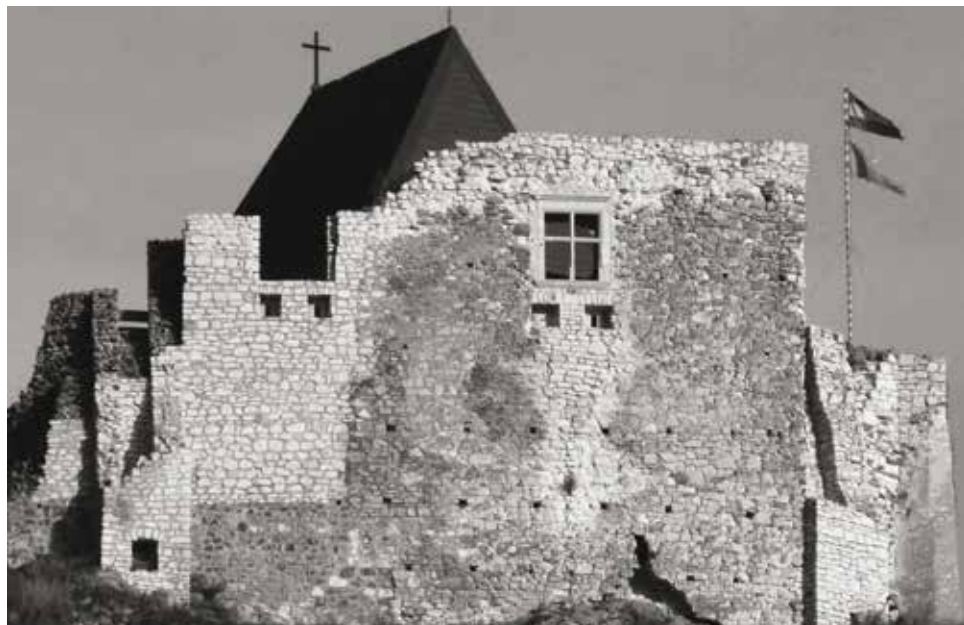
14. kép – A „nyugati hosszú terem” délnyugati falában megmaradt ablaknyílásban elhelyezett reneszánsz ablakkeret-rekonstrukció
