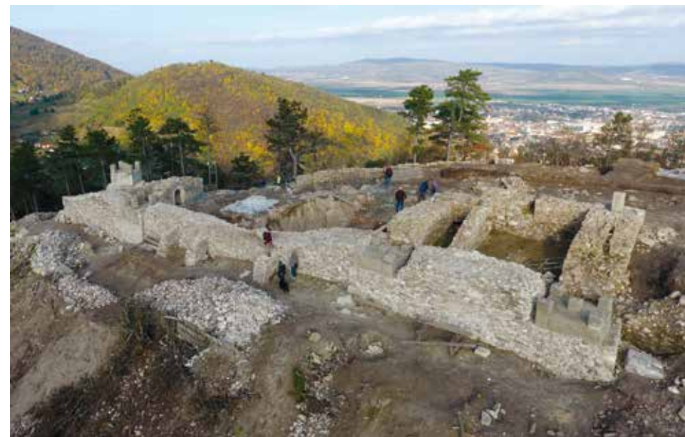
13. kép – Az Északi torony, a támpillérekkel megerősített nyugati várfal és a Nyugati torony a romkonzerválási munkák után. Nagy Attila és Nagy Máté drónfelvétele, 2020. november 7.
