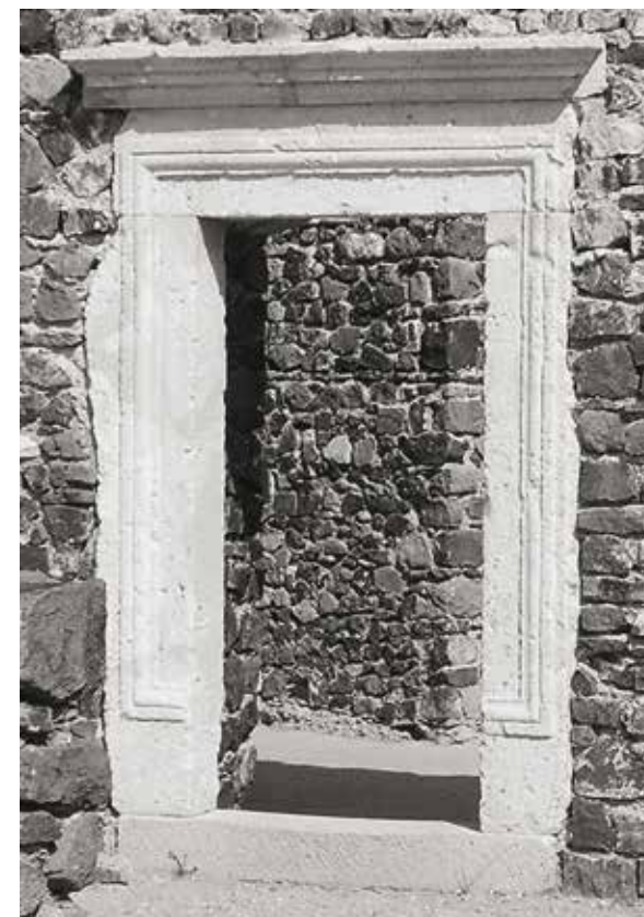
11. kép – A feltáráson előkerült reneszánsz ajtókeret rekonstrukciója a délnyugati palotaszárny lakószintjén
