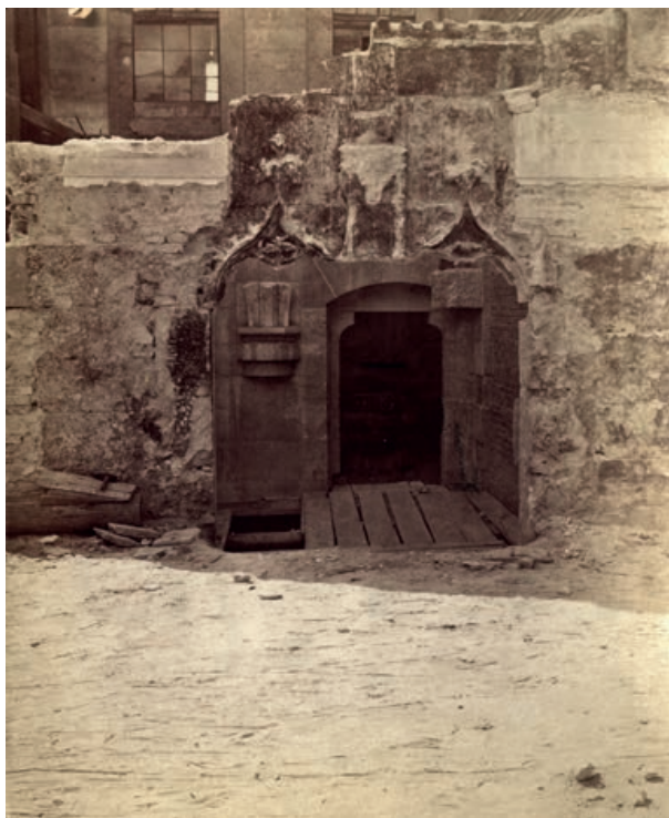
9. Már lebárdolt, de még a befejező finomfaragásra váró fejezet a keleti sekrestye déli falán a szentélybe vezető nyílás mellett, 1878 körül Budapest, Budapesti Történeti Múzeum, Kiscelli Múzeum, Fotótár, ltsz. F.63.357.20
