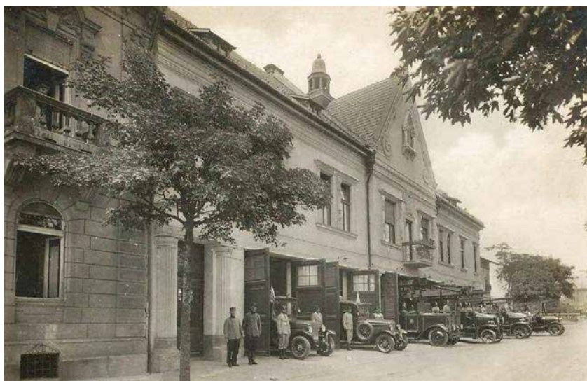
Munkácsy utca 4. Tűzoltó- és mentőállomás. A tűzoltóság épületét 1896-ban adták át, melyben 1928 és 1949 között a mentőállomás is működött.
