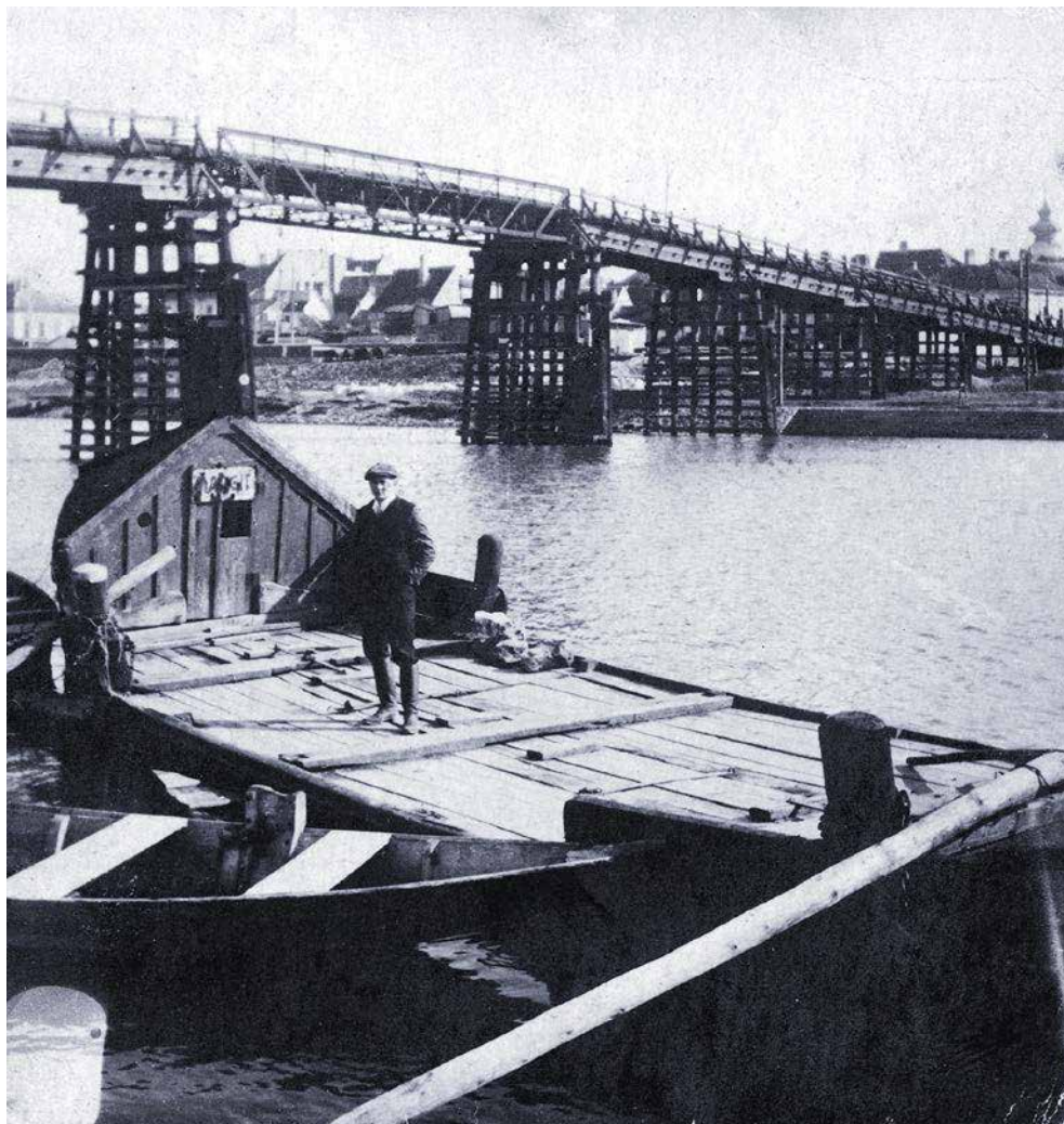
A Kecskelábú híd bontása előtt.
