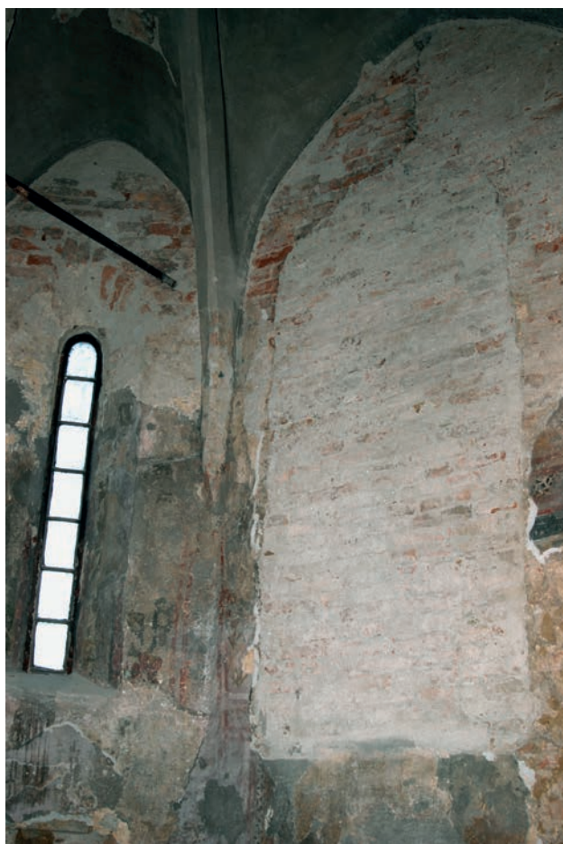
12. sz. kép: A befalazott barokk ablak a középkori szentély déli falán. A szerző felvétele.
