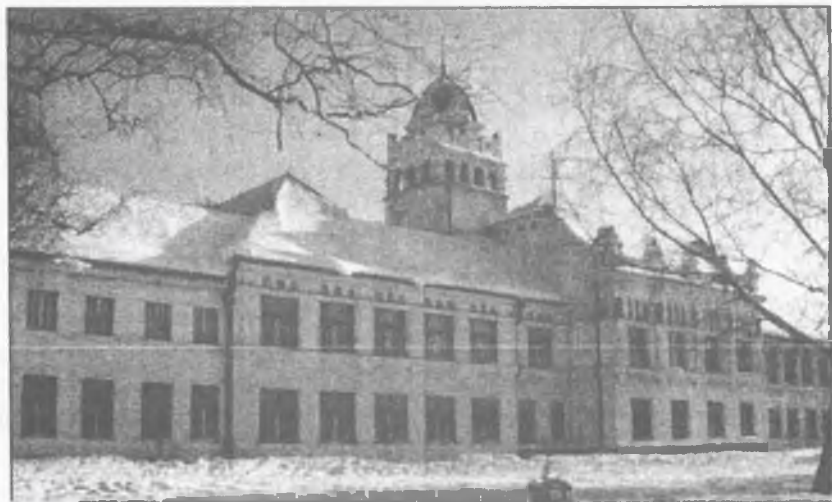
A KÖZPONTI ÉPÜLET DÉLNYUGATI HOMLOKZATA
