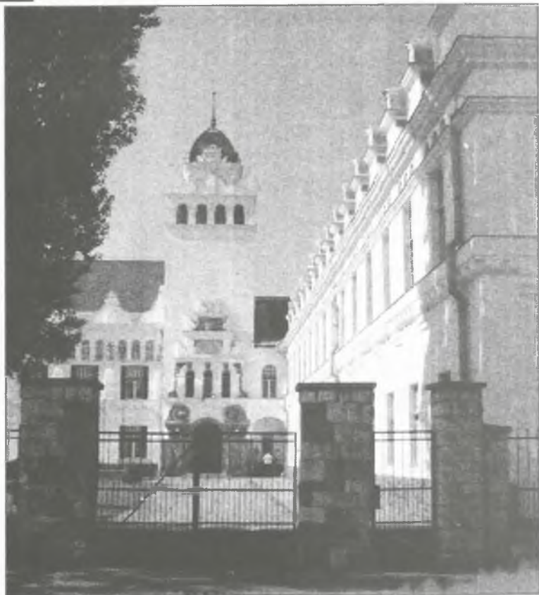
Az épület bejárata
