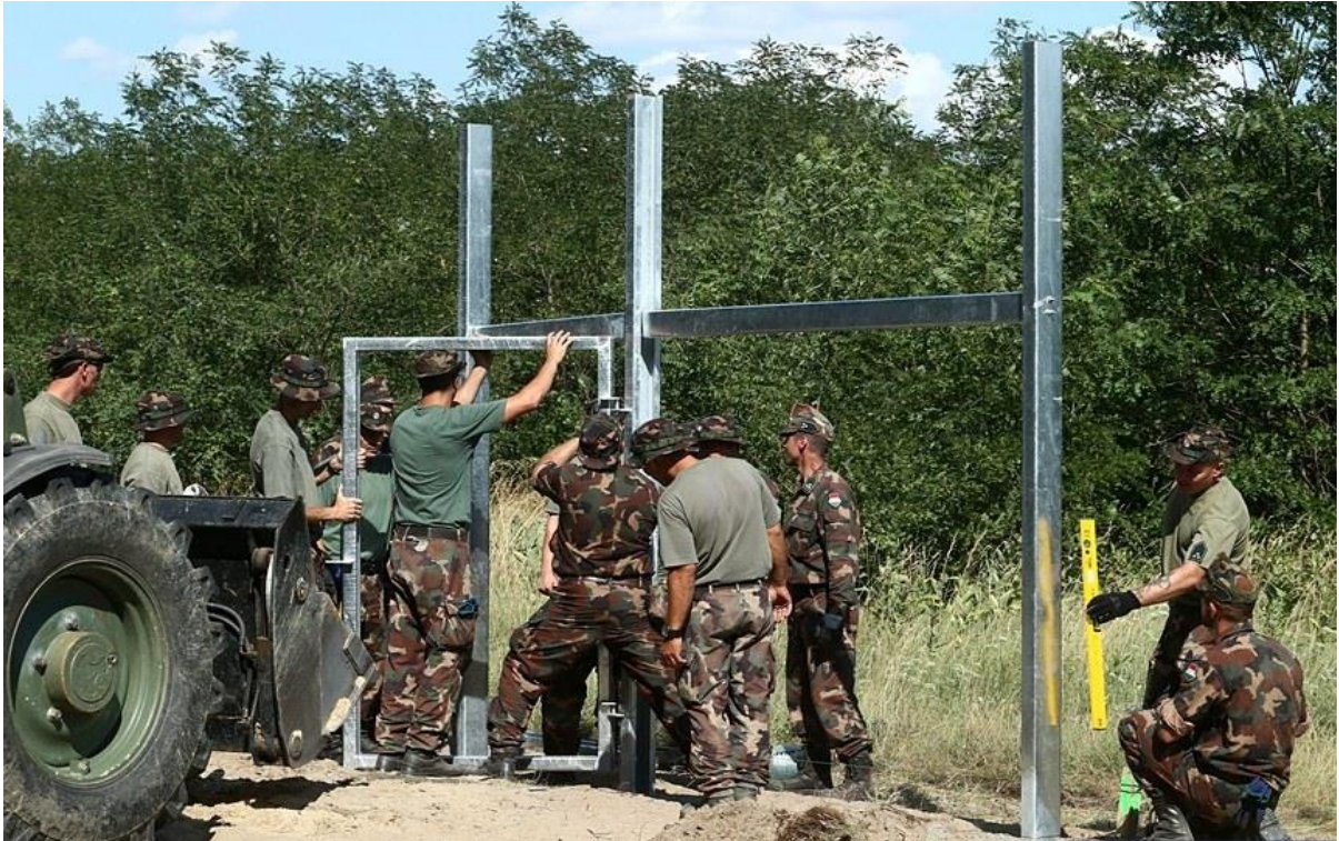
1. kép A kerítés építésének megkezdése.
