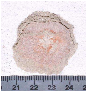
18–19. számú fényképek Becsapódási kráter vakolt (bal) és vaknyílás (jobb) téglafalon
