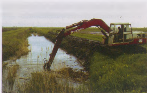
10. ábra. Csatorna kotrás. A gép előtt a náddal, gyékénnyel benőtt csatorna szelvény látható, utána a tiszta vízfelszín marad. Fotó: Izsó Lajos
