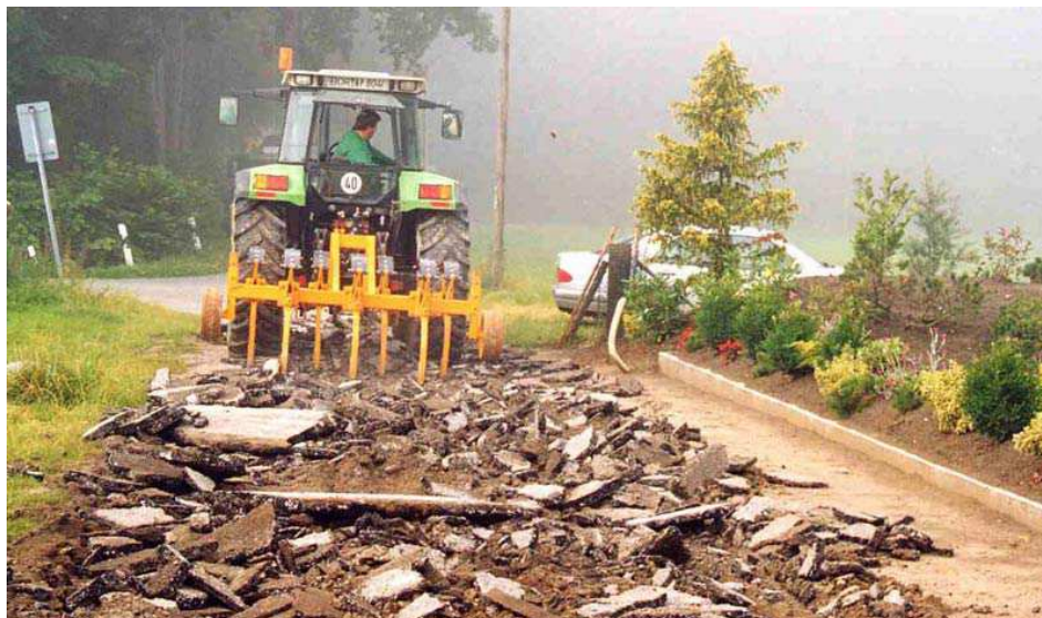
5. kép: Nagyméretű burkolatdarabok felszínre fordítása
