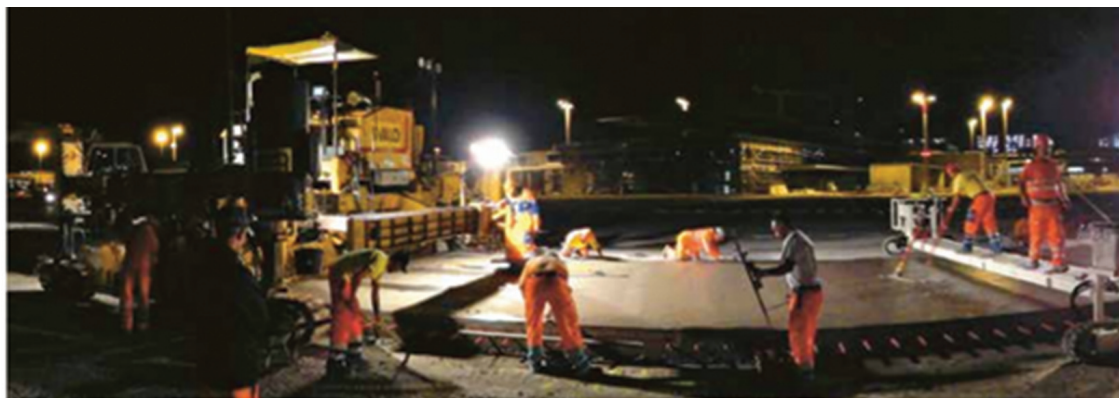
Gépi betonbedolgozás csúszózsálas finiszerrel
