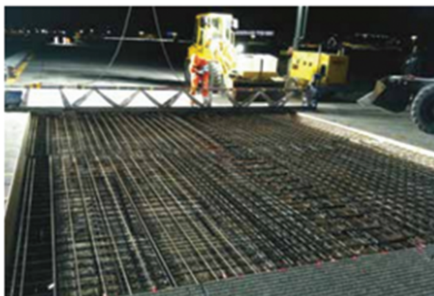
A gyorsbeton lemez számára elhelyezett hálóvasalás
