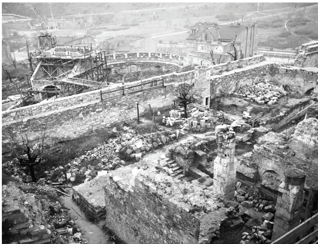
12. A déli udvarok 1955-ben, a fák átültetése és a lépcsőtorny visszaépítése után, a zárt gyilokjáró-mellvéddel (a háttérben épül a déli rondellához kapcsolódó Zsigmond-kori kaputorony).
