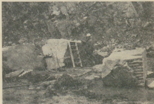
8. ábra. Gránittömb hasítása a bányaudvaron
