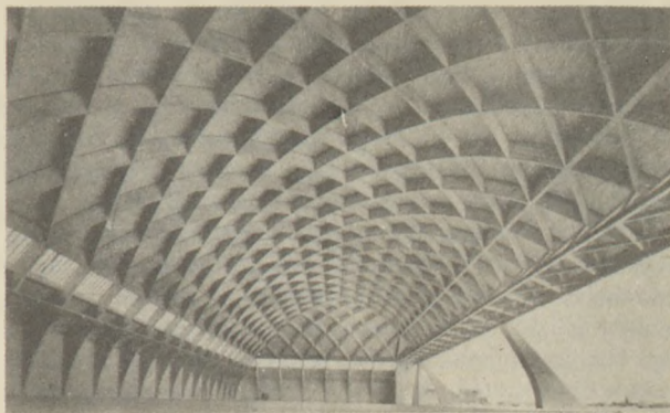
2. fénykép. A ferrocement héjú hangár. Orvieto (1936) [18]
