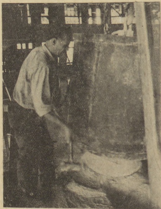
2. ábra. Salgótarjáni Síkiüveggyár. A kemence adagoló-tartálya felett a darukezelő a konténer falának ütögetésével gyorsítja az ürítést
