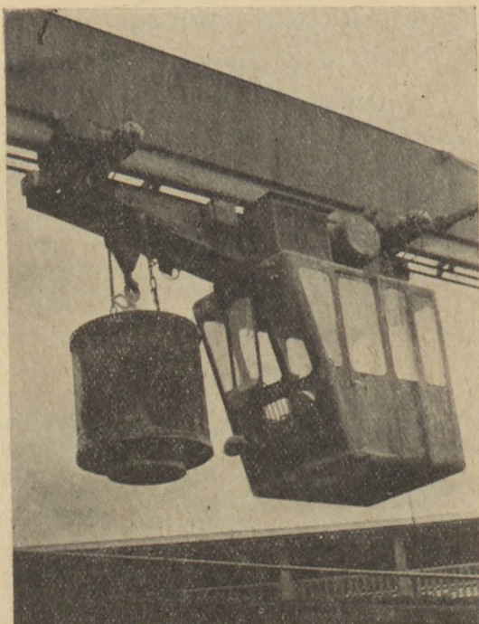
1. ábra. Salgótarjáni Síkiüveggyár. Üvegkeverék szállítása a hutába
