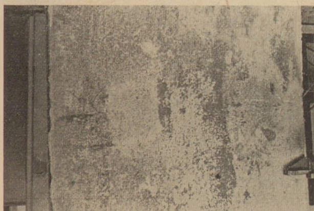
13. ábra. Melaszos kötőgátlóval készített házfűtési panel felülete helytelen tömörítés esetén
