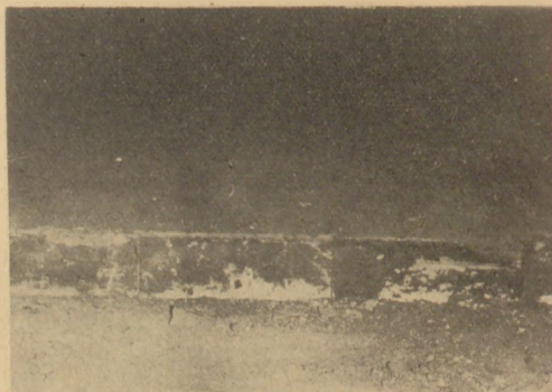
30. ábra. A tűztér fenék minősége finomhengerművi kemence üzemeltetési periódusa után lehűlt állapotban
