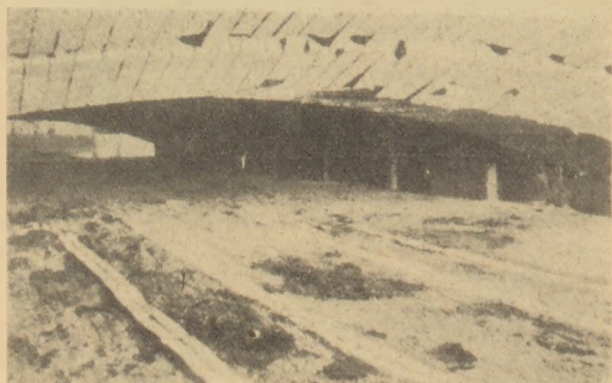
3. ábra. Krómérc betonba ágyazott keramikus csúsztatósín 2 3/4 évi üzemeltetés után
