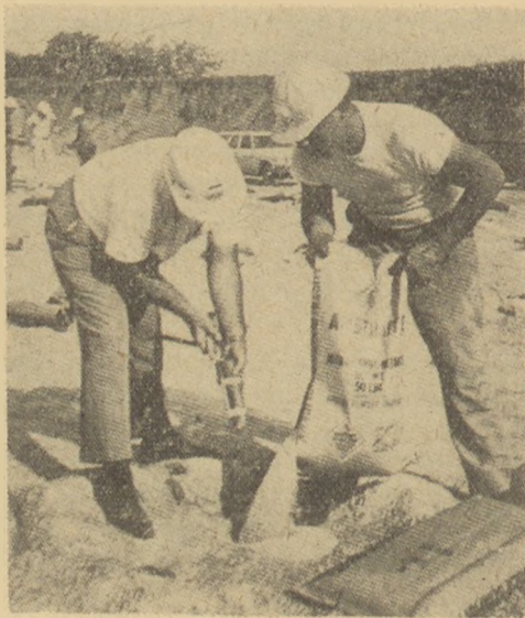
6. ábra. Beöntik az indító hatást fokozó töltetreszt, a boostert — ez esetben kétrészeset — készletben tartják. (Austin Powder felvétel)
