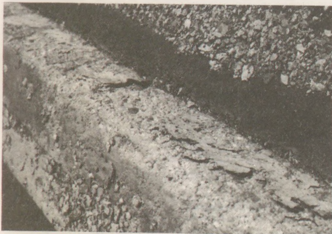
1. ábra Fagy és sózás okozta károsodás tipikus példája
