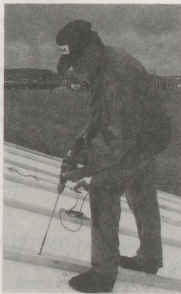
1-2. ábrák A hőszigetelő elemek fektetése és rögzítése
