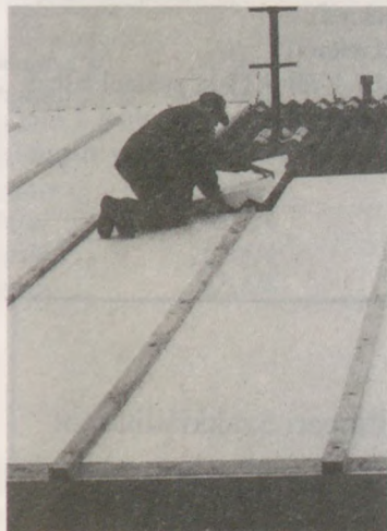
1-2. ábrák A hőszigetelő elemek fektetése és rögzítése
