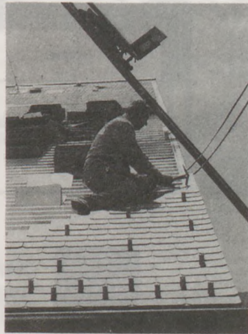
3. ábra Fedési munka a felülfedésnél
