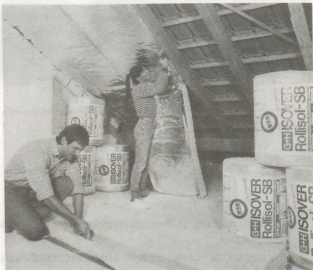
2. ábra Tetőtér hőszigetelése
