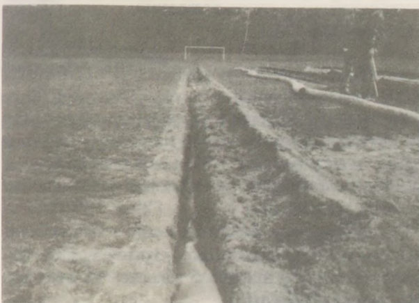
4. ábra Labdarúgópálya vízelvezetése
