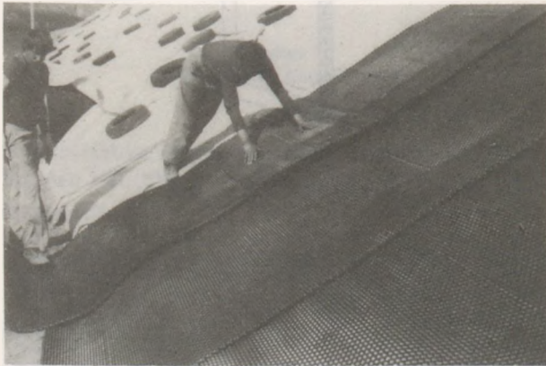
8. ábra Veszélyeshulladék-tároló DRAIN-AWAY felületszivárgó rendszer (Aszód – Galgamácsa)
