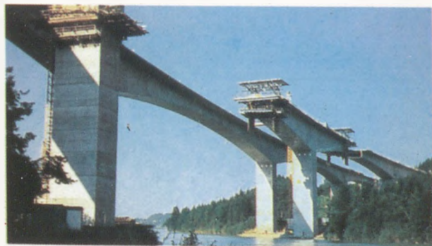
Hidszigetelés speciális bitumenes szigetelőlemezekkel, VILLAS ISOVILL hidszigető módszerrel
