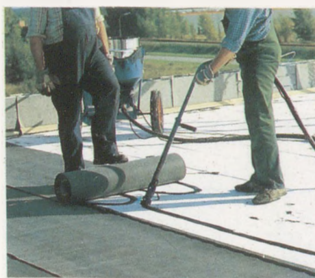
Bitumenes szigetelőlemezek tektetése VILLAS adhezív hidegragasztóval. Nagy termelékenység, tűzveszély nélkül!
