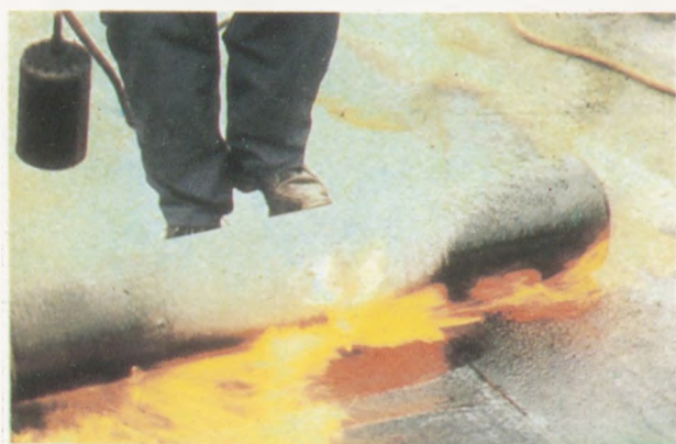
Csapadékvíz elleni szigetelés modifikált bitumenes hegeszthető szigetelőlemezekkel
