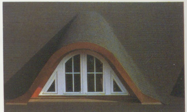
Zsindelytető bitumenes tetőzsindelyekkel
