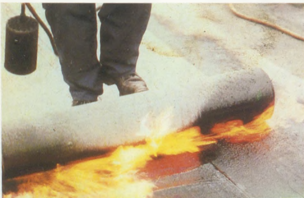
Csapadékvíz elleni szigetelés plasztomerbitumenes hegeszthető szigetelőlemezekkel
