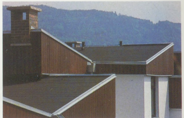
Csapadékvíz elleni szigetelés elasztomerbitumenes színes alpesi lemezekkel
