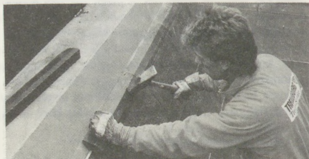
6. ábra A kopásálló gumi elem szerelése
