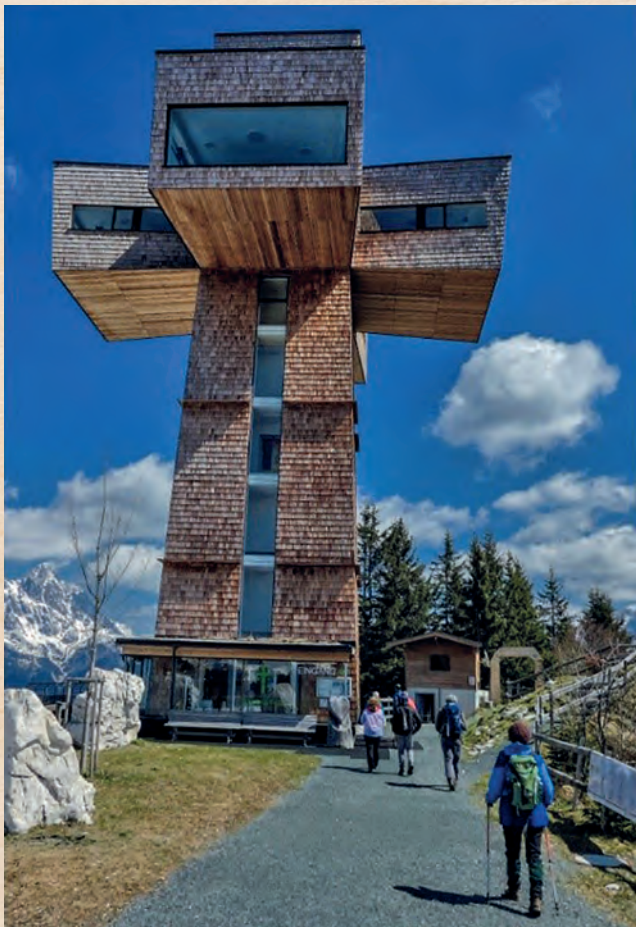
Keresztformájú kilátótorony az Alpokban teljes egészében kezeletlen vörösfenyőből. A legértékesebb fa építőanyag.
