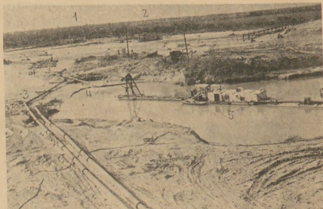
6. ábra. Úszókotrók és zagyvezetékek a Slatioara-i üzemben
