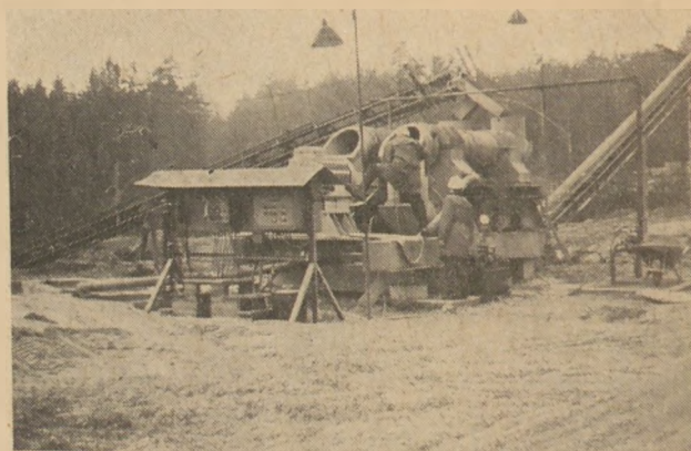
10. ábra. Vibrációs tandem kavicsmosódob az Ottendorf-i üzemben (NDK)
