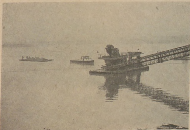
7. ábra. Vontatott és önjáró fenékkürítős uszály. Előbbi forgópontonra szerelt kotróhoz közeledik, ahol vizalatti depóniát képez.
