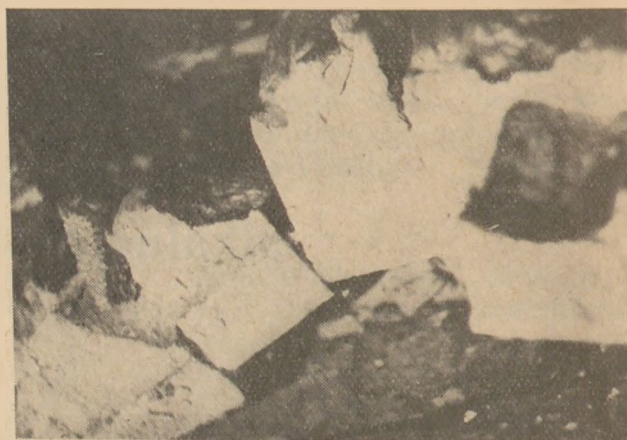
3. ábra. Tűzakna állapota hőmérsékletingadozás hatására
