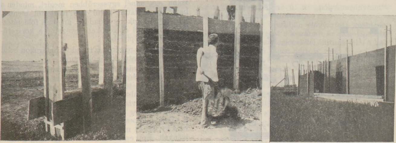
9—11. ábra. A vert földfalak cövekezése; a szaluzat emelése; az elkészült földfal
