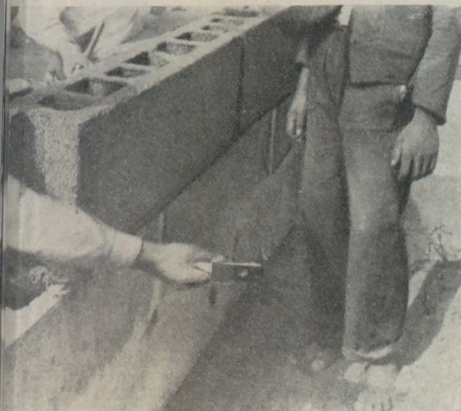
4-5. ábra. — Falazás előgyártott nagyméretű könnyűbeton-idomokkal.
