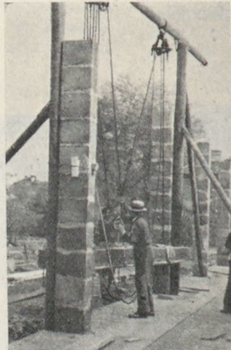
15. ábra. Pillér építése saluzás nélkül.
