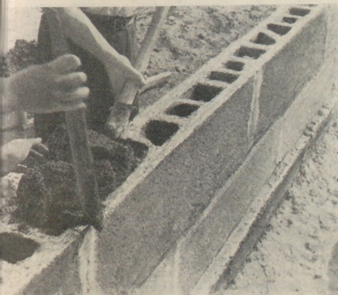
6-7. ábra. — Belső falpillérek kialakítása. Falazás előgyártott nagyméretű idomokkal.
