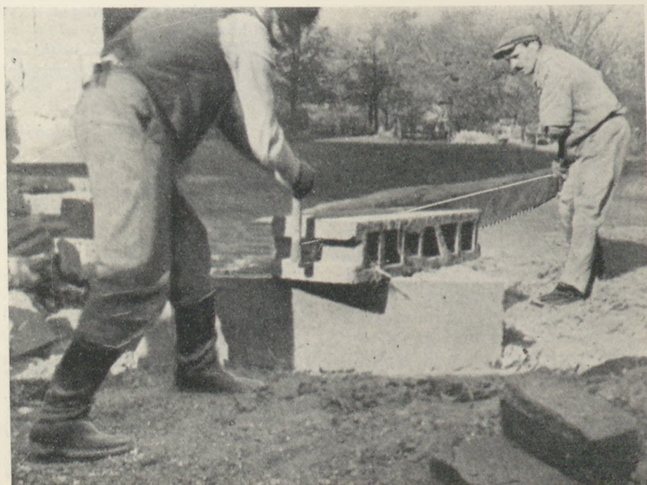
3. ábra. — A könnyűbeton fűrészeltető.
