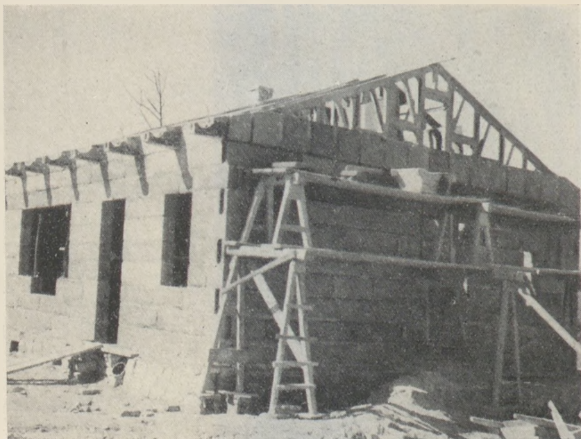
10—11. ábra. Családiház építése könnyűbetonból Szobon.
