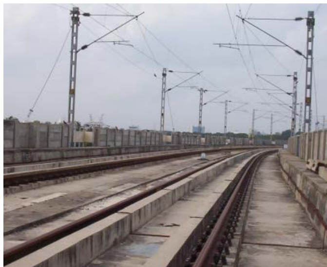
3.7.ábra. FFC-rendszerű felépítményrendszer [2]
