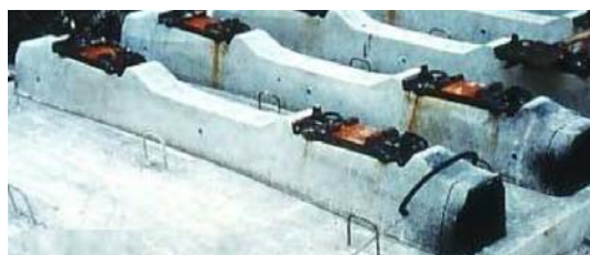
3.1. ábra: Az első, 1972-ben lefektetett Rheda-rendszer [2]
