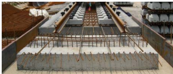
1.5. ábra: Pontszerű alátámasztás
