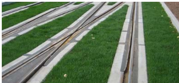
1.6. ábra: Folyamatos alátámasztás
