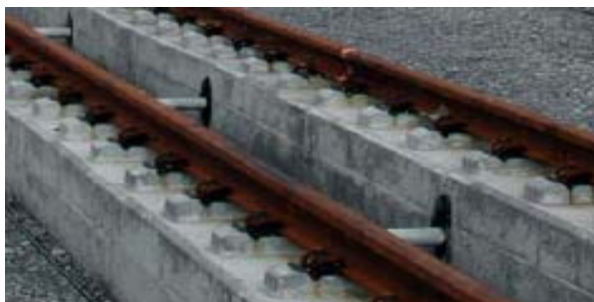
1.3. ábra: Hosszaljas pályaszerkezet
