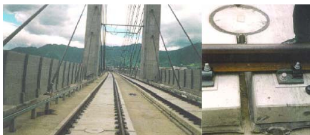
3.8. ábra. Injektált ágyazású, előregyártott betonlemez-es Shinkansen-rendszer [2]
