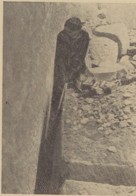
4. ábra. Függőleges részvágás a sziklafal tövében
