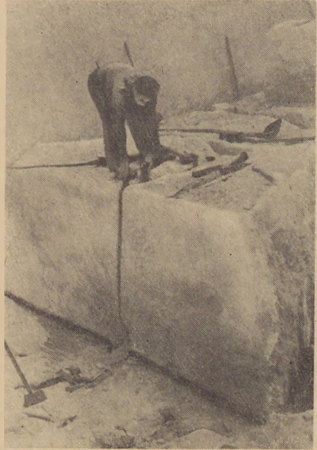
6. ábra. Feklapjáról felfeszített tömb hasítása
