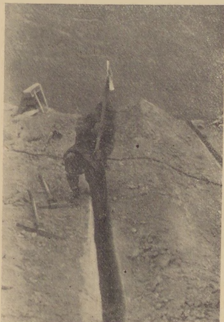
3. ábra. Függőleges részvágás tömbkőfejtéshez
