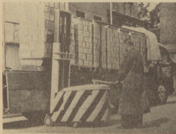
7. ábra. Megrakott zsámoly tehergépkocsira helyezése
