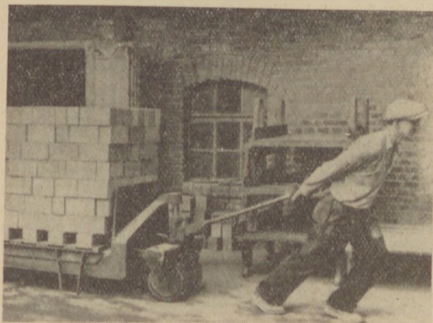
16. ábra. Kemence-kihordókocsi rakodósablonnal
