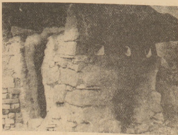
8. ábra. A kemence oldalnézetben, jól látszanak az égéstermékek elvezetésére szolgáló nyílások
